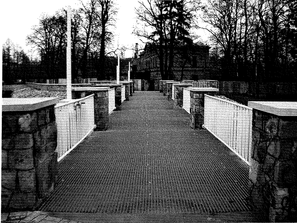
Fot. 3 Kładka z elementów kratowych WEMA
